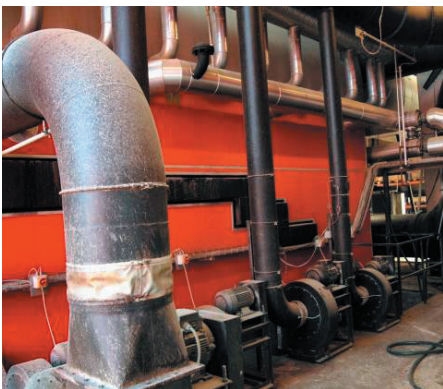
9: ... afbrændingen af bark i et gigantisk stokerfyr - temperaturen er 1050 grader ...
